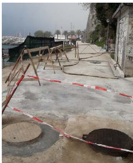
Spajanje starog i novog sistema – završeni radovi
